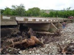
INFRAESTRUCTURA DE PUENTES
